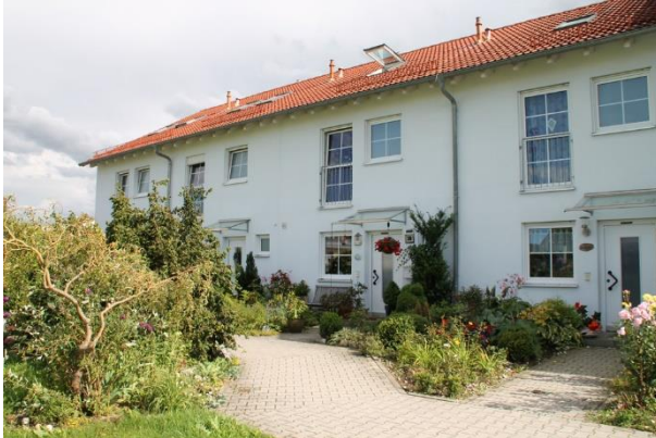
Vorderansicht mit Eingangsüberdachung
