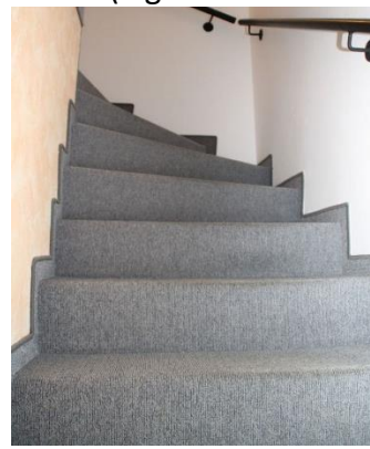
Treppe von UG bis DG
